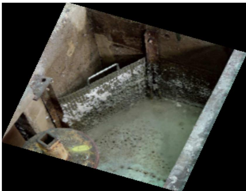
Separador de reja en arqueta para control de pluviales para retención de granzas y triturados
